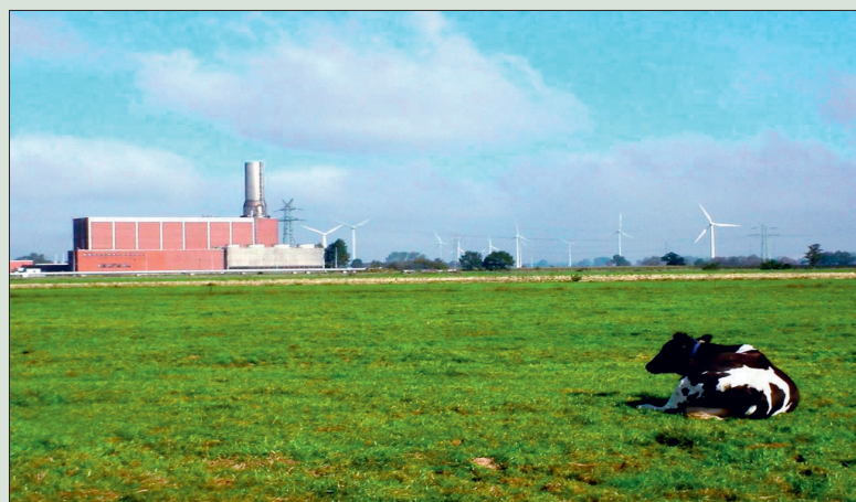
Figur 2. Huntorf CAES-anlæg. Anvendt med tilladelse fra E.ON Kraftwerke GmbH [2].
