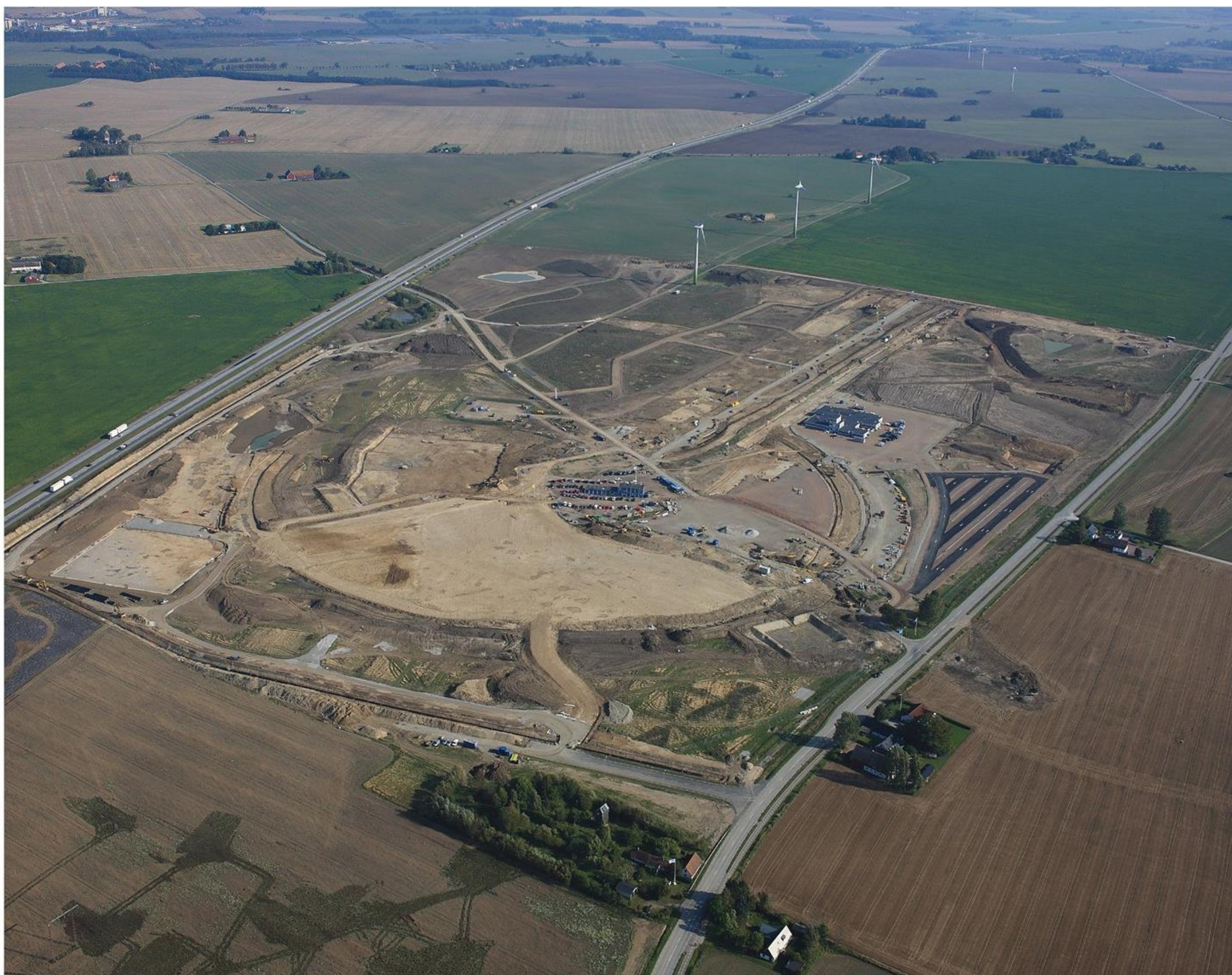
Her skal ESS bygges.
