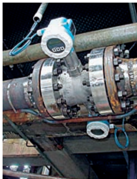
Redundante sensorer benyttes i olieindustrien.
