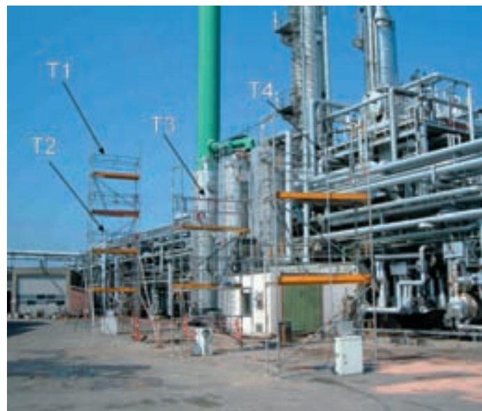
Figur 3. Måling på tjæredestillationsanlægget.
