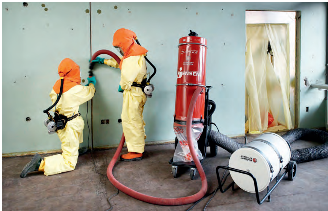
Personlige værnemidler og støvsuger skal leve op til særlige krav i forbindelse med udsugning af PCB-holdige fuger af en betonvæg.
