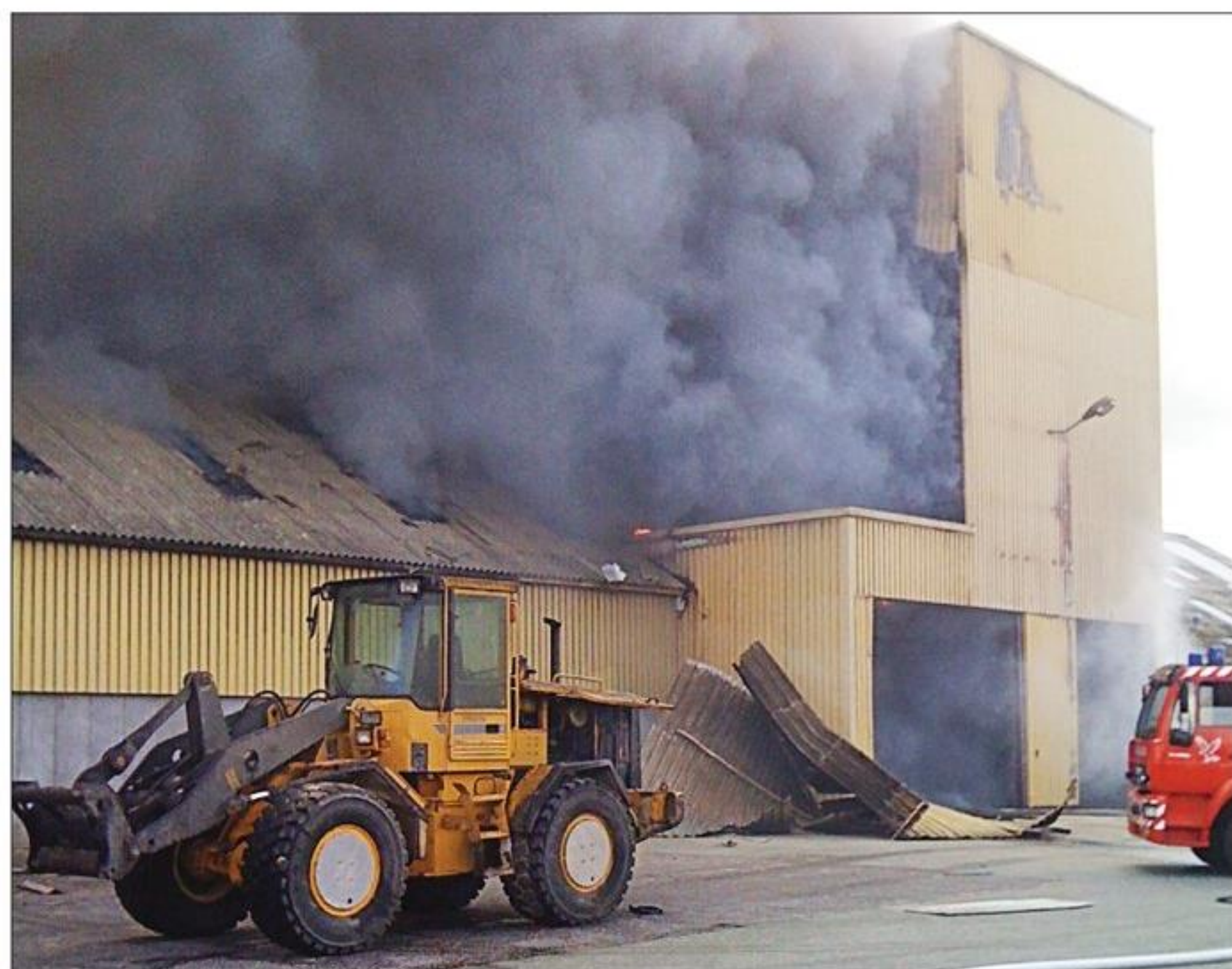
Foto taget ca. 1 time efter eksplosionen. Frontlæsseren er magen til den forulykkede maskine inde i bygningen. Bemærk trykskader på vægpaneler og tagplader (Kilde: Beredskab Vesthimmerland).
