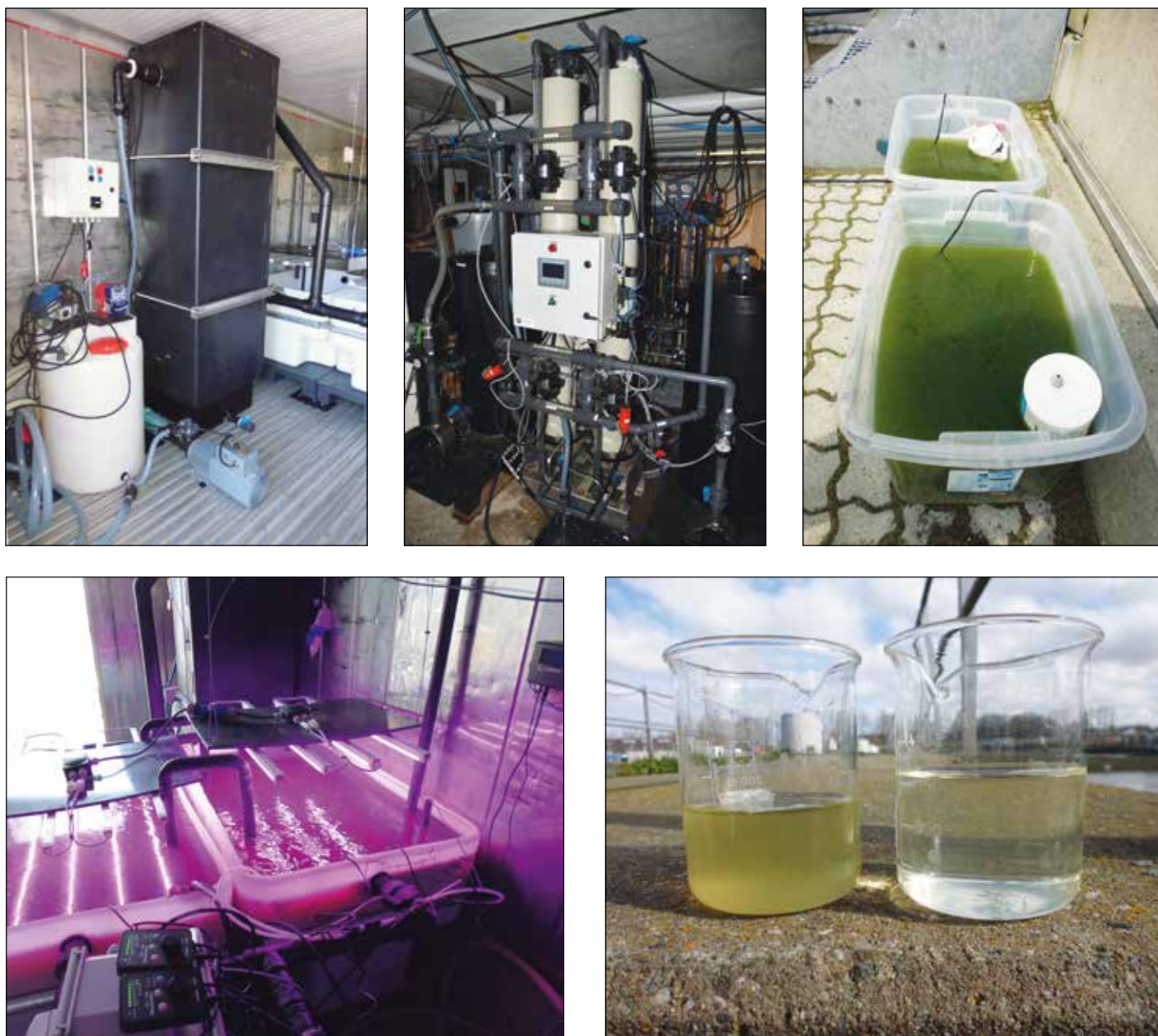
Figur 2. Billeder fra pilotanlægget under drift samt faser i projektet. Fra venstre ses forbehandlingstrinnet (biosorption), filteranlæg, mikroalgekultur leveret af DTI og mikroalge-produktionskar med LED-lys og prøveudtag før og efter filtrering.
