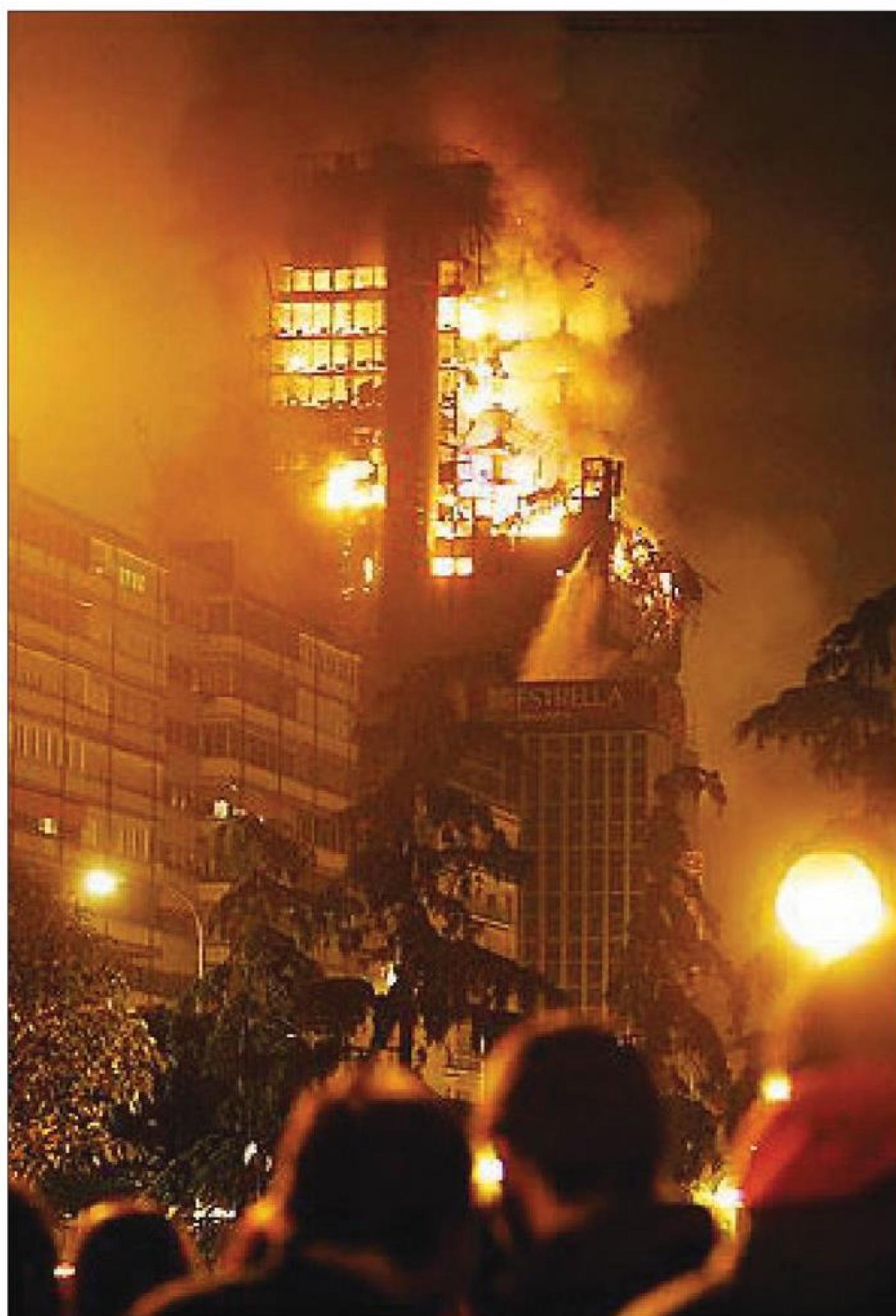
Figur 1. Windsor-bygningen i Madrid, der delvist kollapsede efter en omfattende brand i 2005. Billede fra reference [6].
