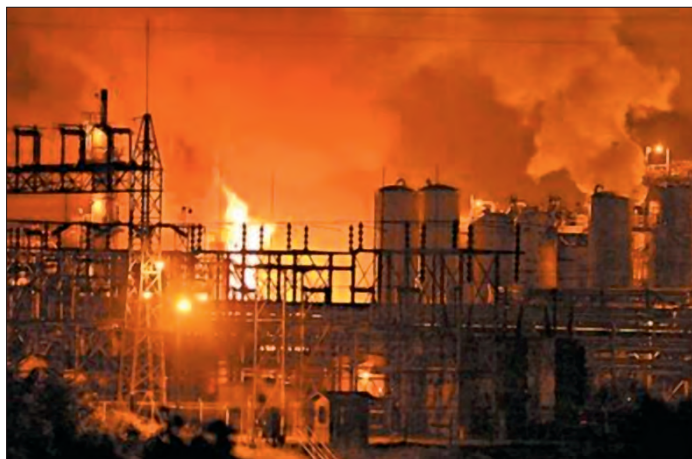
Figur 4. Brand hos Bayer CropScience efter eksplosion af destruktionsreaktor for methomyl. Kilde: Coalition against BAYER Dangers (Germany).
