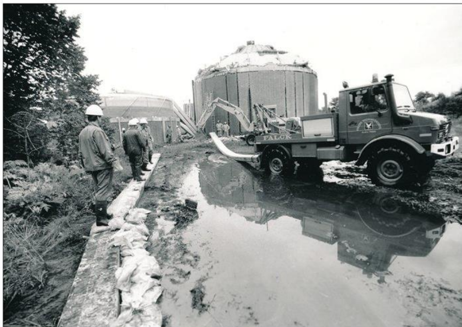
Sandsække forhindrede slammet i at løbe ned i den nærliggende bæk. Bemærk væltede betonpiller over anden tank. Foto: Vejle Amts Folkeblad.
