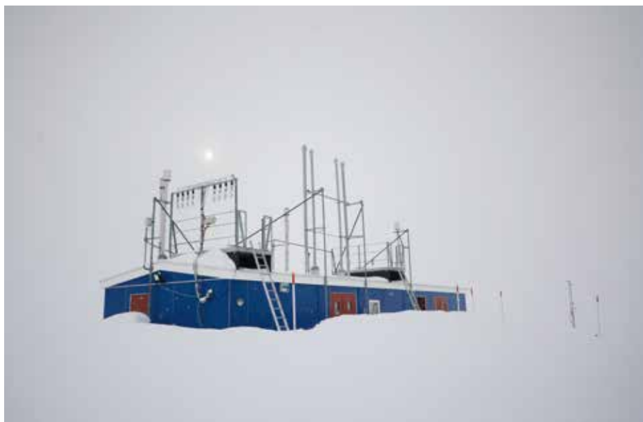
Atmosfære-målehuset på Villum Research Station med specielle prøveindløb til aerosol-målinger og til gasser, samt skorstene for at fjerne luften, der suges ind i huset, så vi undgår kontaminering af vores egen prøveluft.
