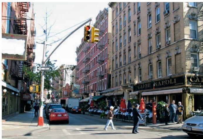
Gadeslugter eller »street canyons« er almindeligt forekommende i projektområdet. Gadeslugter med tæt randbebyggelse på begge sider af vejen resulterer i forhøjede koncentrationer, fordi spredningen er begrænset af bygningerne.
