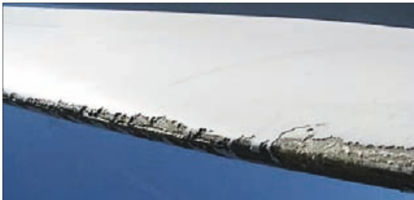
Figur 1. Vindmøllevinge med skade på vingens forkant efter regnerosion. Gengivet fra [1].
