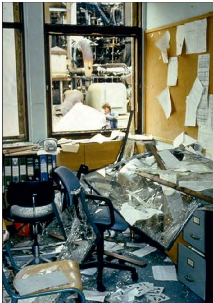
Figur 3. Vindue med beskyttelsesfilm blæst ind af eksplosionen. Filmen har klart reduceret antal glasfragmenter (Kilde: Bjerketvedt and Mjaavatten, 2005).
