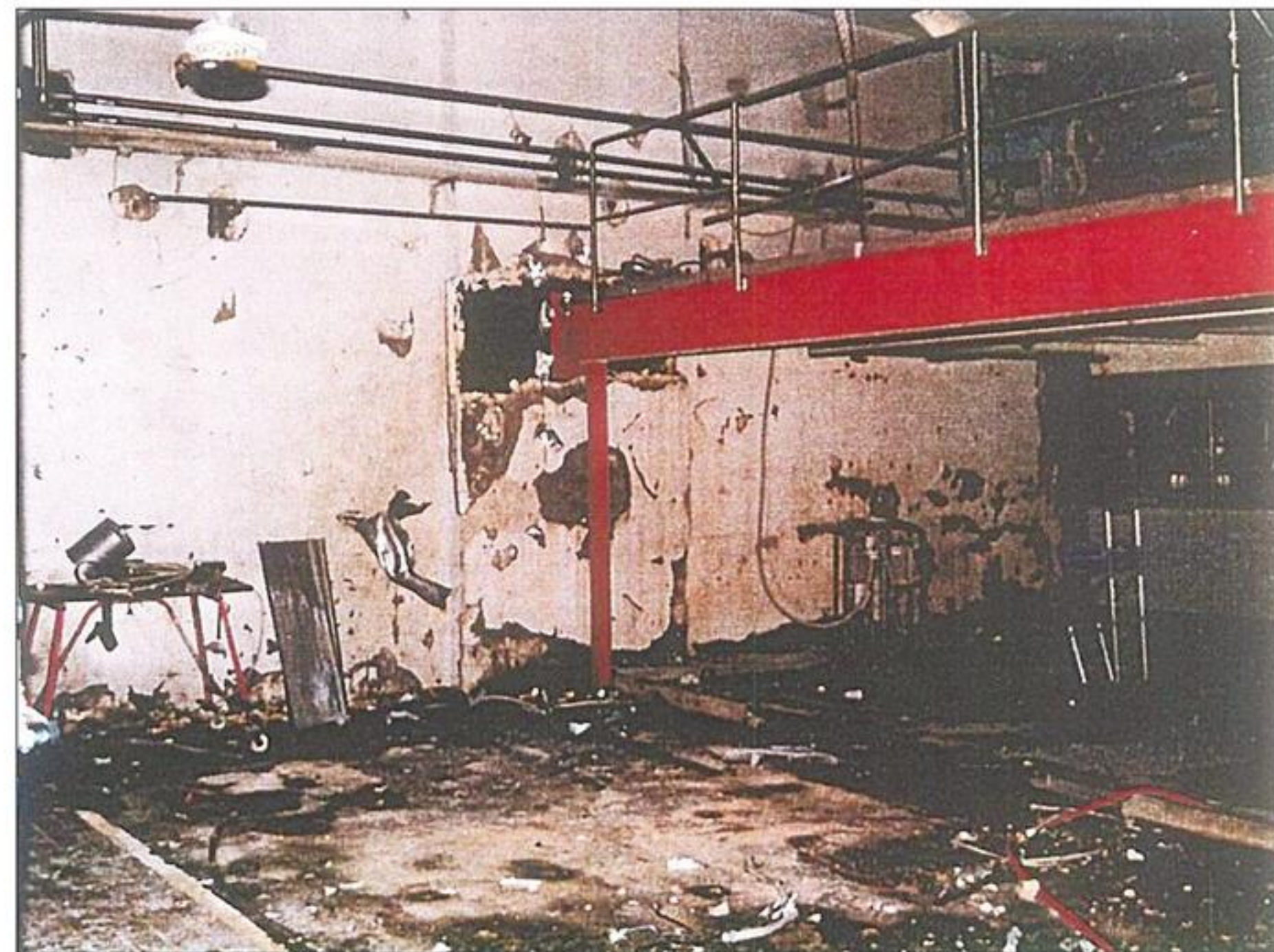
Ulykkestanken detonerede med så stor kraft, at fragmenter bo-rede sig ind i kælderen's meget solide betonvægge.
