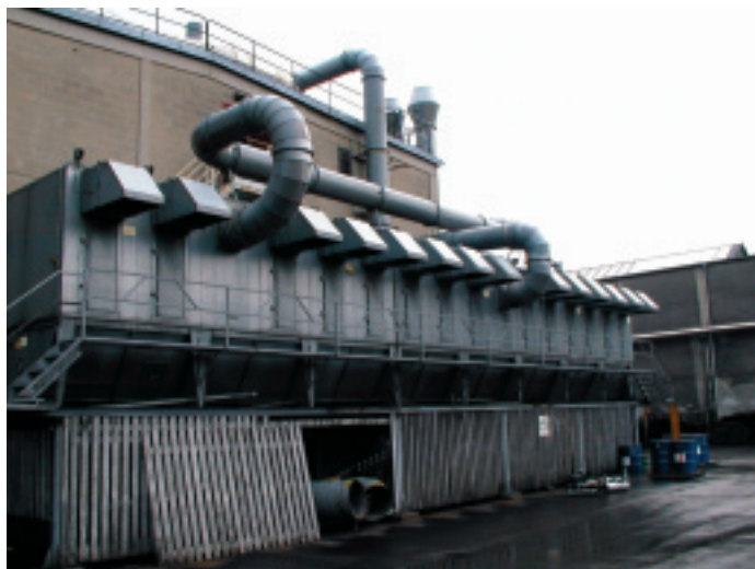
De traditionelle posefiltre med et firkantet nedadvendt afkast fra hver filtersektion.
