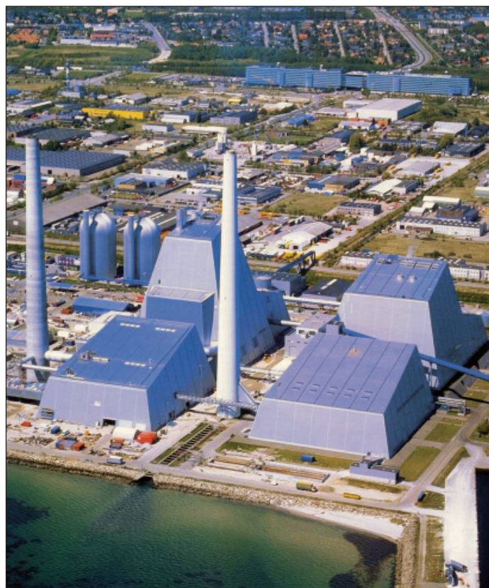
Figur 1. Avedøreværket. Til højre i billedet ses blok 1 og til venstre den nye blok 2. De to bageste bygninger i billedet (for hver blok) er kraftværkskedlerne, hvor brændslet brændes af, mens de to forreste bygninger (for hver blok) indeholder bl.a. de våde røggasafsvovlingsanlæg.
